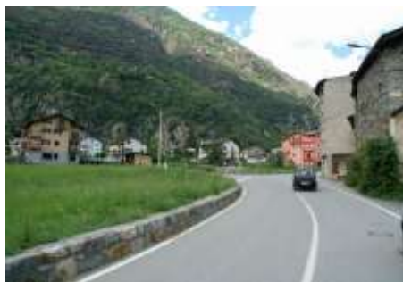
Foto 12 - Edifici in via Casale Stanga
